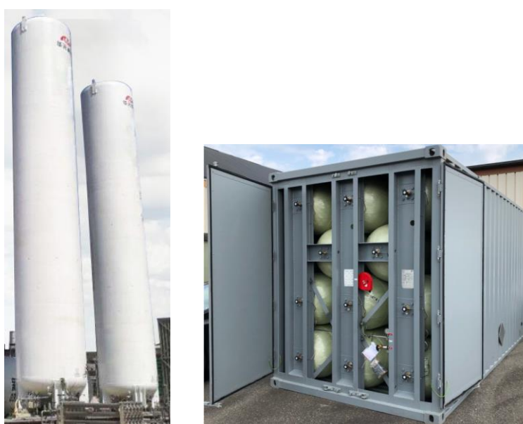
Obr. 19 – Příklad možného řešení akumulace vodíku, vlastní zpracování.
